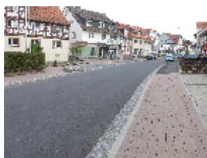
Die sanierte Paul-Frankfurth-Straße
